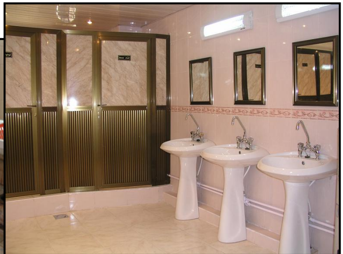
Nassräume vorher und jetzt
