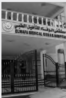
Das Al Wafa Rehabilitation Hospital: unser Projektpartner
